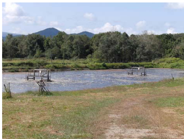
図9 澱粉工場の沈殿池
