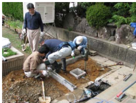
▲手押しポンプ周辺の整備作業
